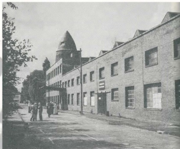
La fabbrica Glanzstoff & Courtaulds all'interno dello Straflager AK 96 di Colonia (foto del 1988 di C. Sommaruga)
